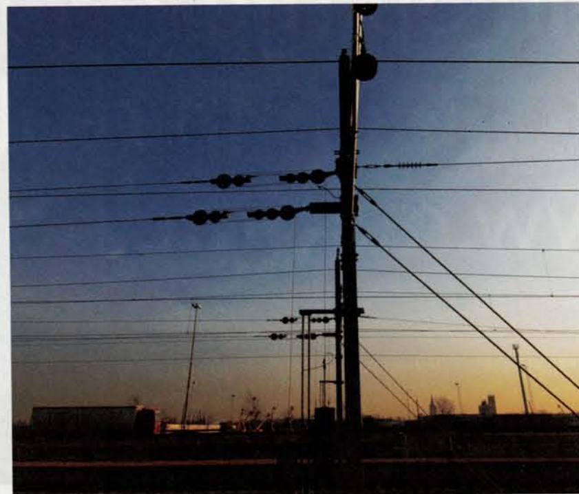
Elektrische locomotieven zijn een stuk milieuvriendelijker
